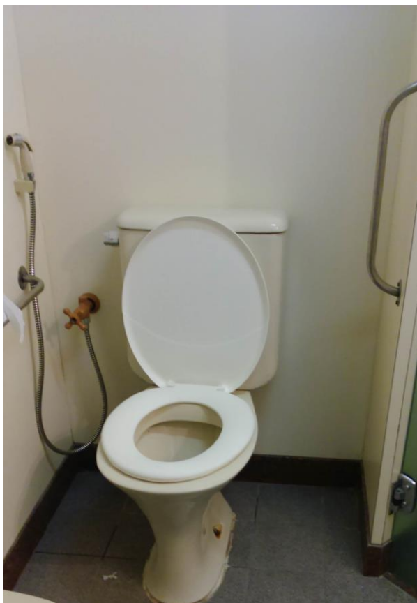
Figura 13 :Vaso sanitário com barras de apoio dispostas próximas nas laterais.
