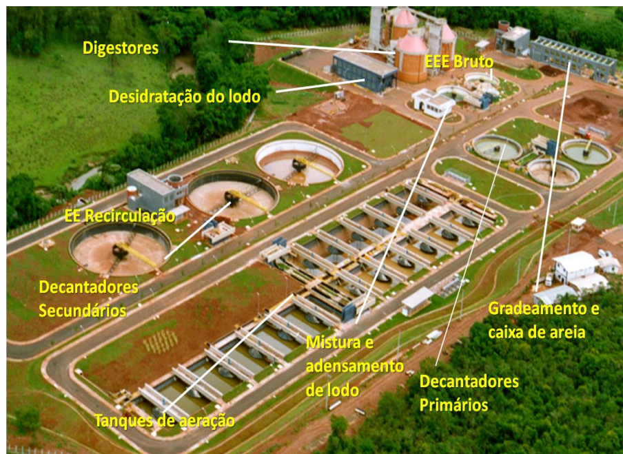
Figura 8: Unidades de processamento de lodo
