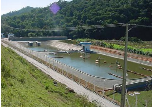
Figura 6: Sistema de Lagoas Aeradas
