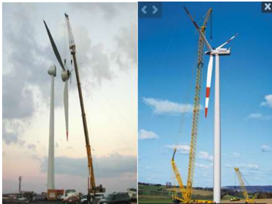
Figura 16: Montagem de turbina eólica Fonte: Copel (2007).
