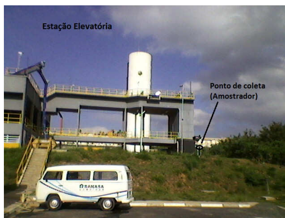
C) Estação elevatória: Coleta por um amostrador localizado na parte inferior
