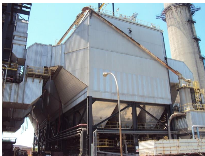
Figura 6 Precipitador eletrostático.
