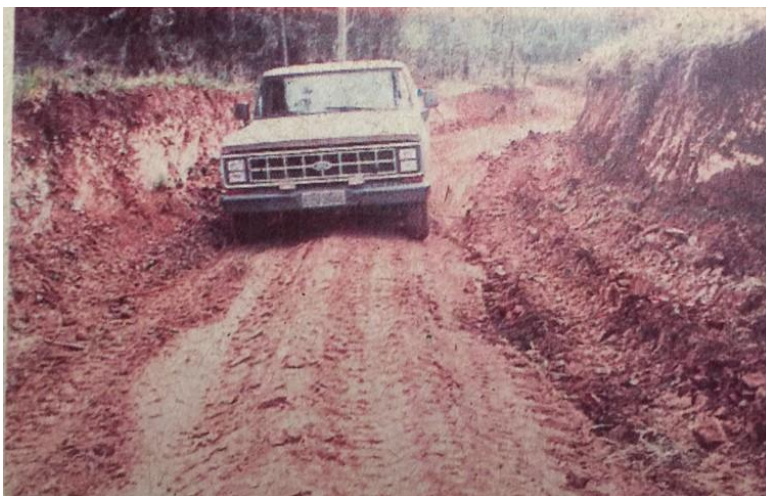
Figura 9 – Condição inadequada de uma seção transversal. Fonte: Baesso e Gonçalves (2003).
