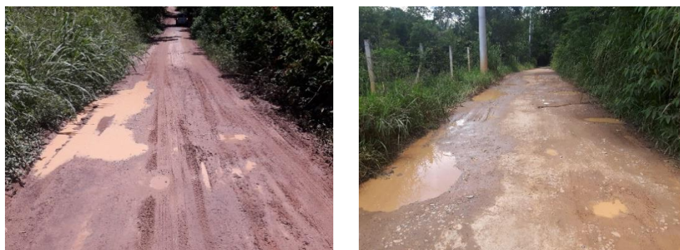
Figura 35- Drenagem inadequada com formação de poças na pista. Sendo Amostra 4 (esquerda) e Amostra 19 (direita).
