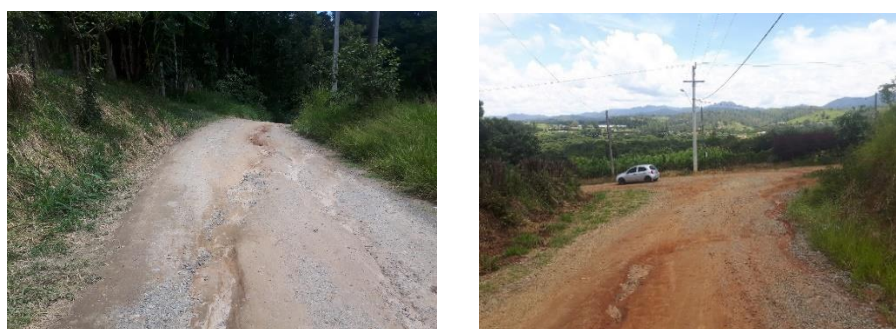
Figura 37- Erosão linear nas amostras 3 (esquerda) e 10 (direita). Fonte: Autor (2018).
