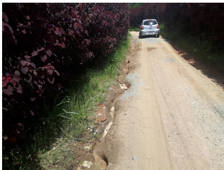
Figura 36 - Valeta improvisada e erosão linear. Fonte: Autor (2018).
