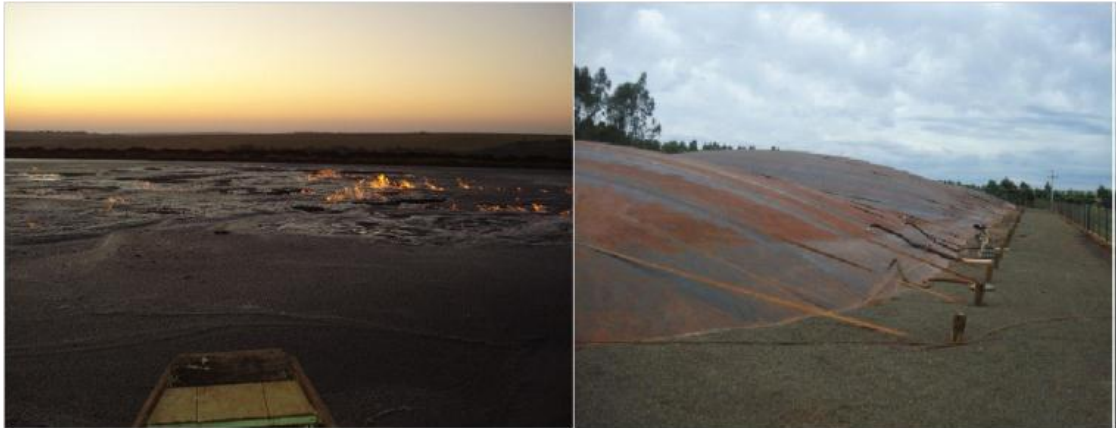
Figura 2 – Vistas gerais de uma lagoa de estabilização: a) sem cobertura e combustão espontânea b) lagoa coberta com PEAD
