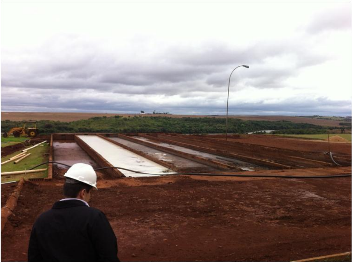
Figura 9 – Valas para retenção de sedimentos de efluentes de fecalaria
