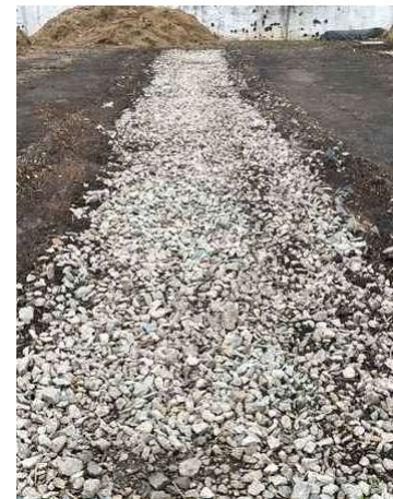
Figura 12. Processo construtivo pátio de compostagem Lapa
