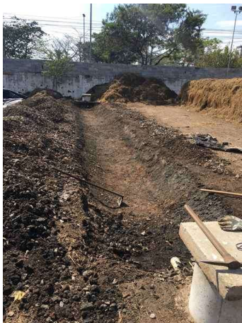
Figura 10. Processo construtivo pátio de compostagem Lapa
