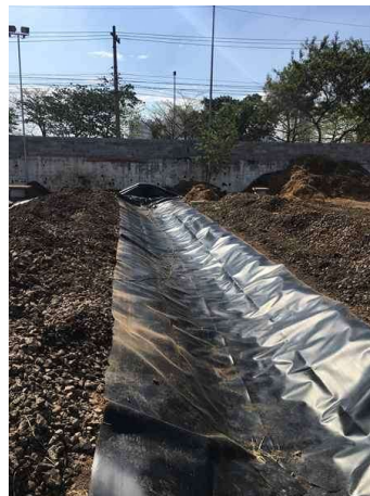
Figura 11. Processo construtivo pátio de compostagem Lapa
