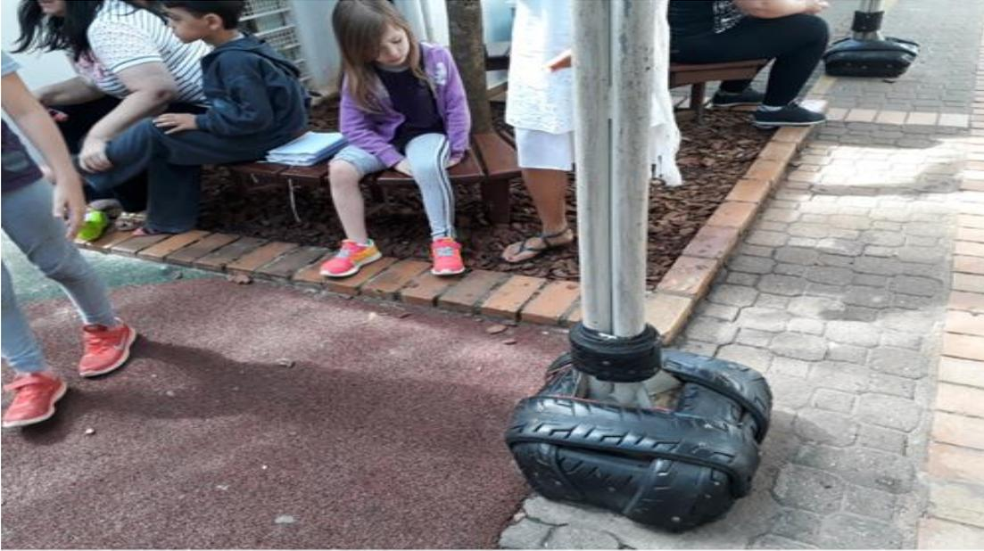
Figura 58. Piso permeável e utilização de material reciclado na área de lazer
