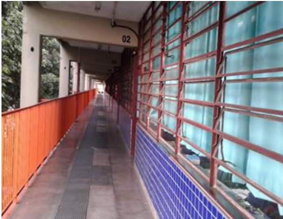
Imagem 10 – Acesso às salas de aula
