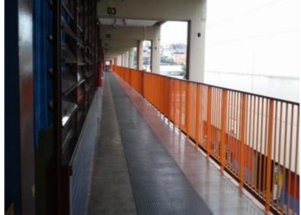
Imagem 11 – Corredor da escola
