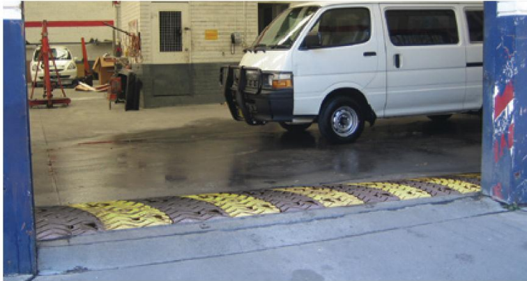
Imagem 14: Se o piso da oficina é bem vedado, a oficina pode ser contida com uma pequena rampa de concreto ou de borracha flexível ao longo das portas.
