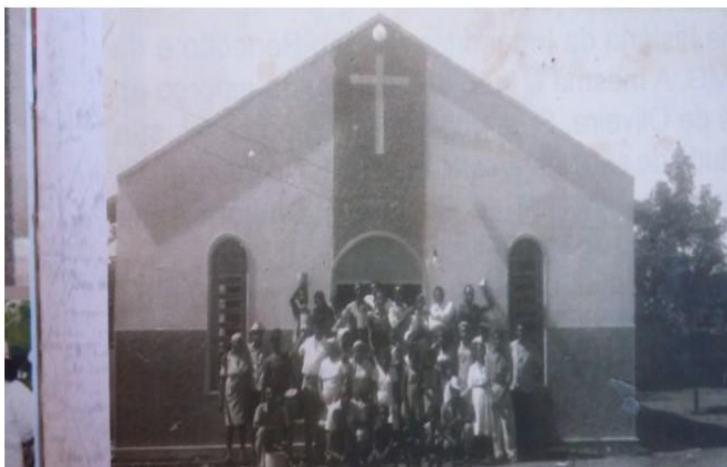
Figura 1 - Imagem da construção da Capela de São Benedito -1971
