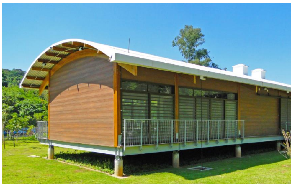
Figura 26. Estrutura metálica de sustentação da sede Fonte: Atlas da Mata Atlântica (2019)
