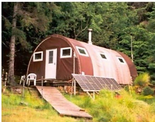
Figura 11. Sistema fotovoltaico autônomo Fonte: Recuperado de “Desenvolvimento de conversores estáticos para sistemas FV autônomos” de Imhoff (2007).
