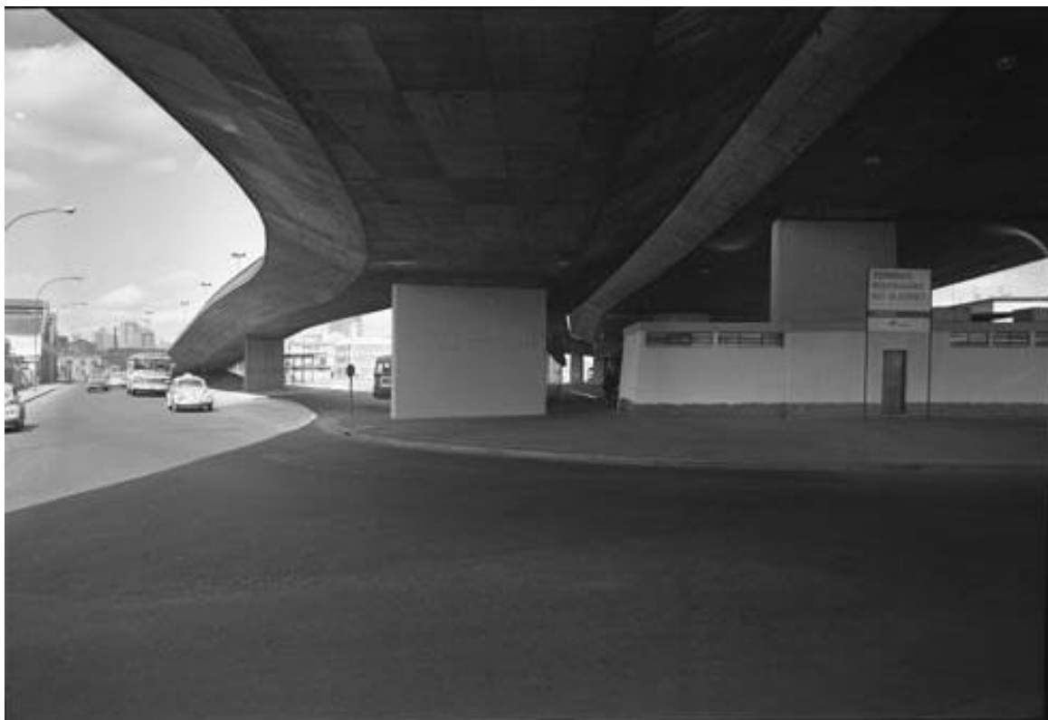
Figura 3.2. Estação de embarque e desembarque para o litoral, nos baixios do Viaduto do Glicério, em 1975. Fonte: Acervo Fotográfico do Museu da Cidade de São Paulo.
