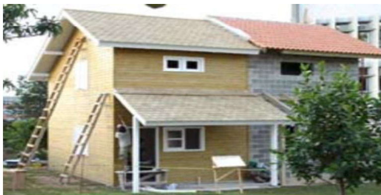
Figura 12 – Habitação popular construída pela TECHO
