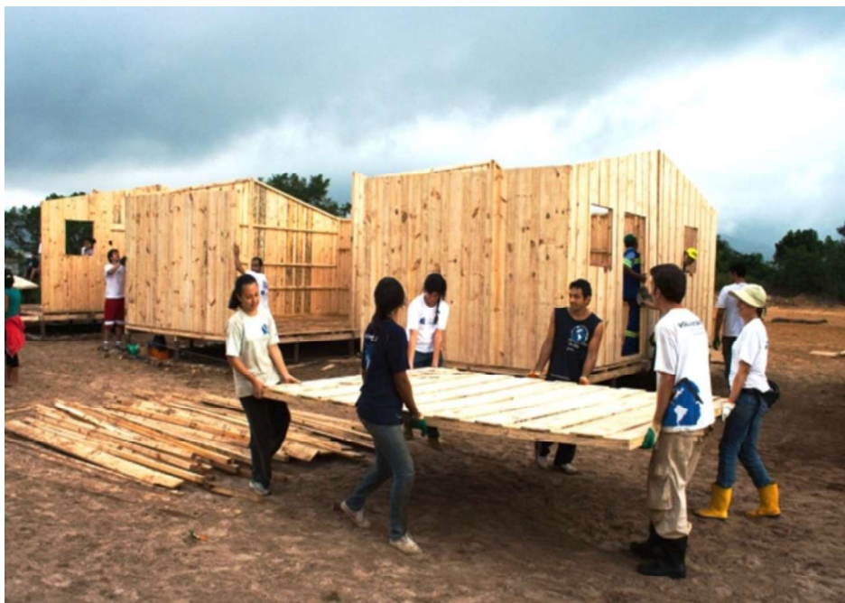
Figura 9 Construção das 200 casas em Curanilahue
