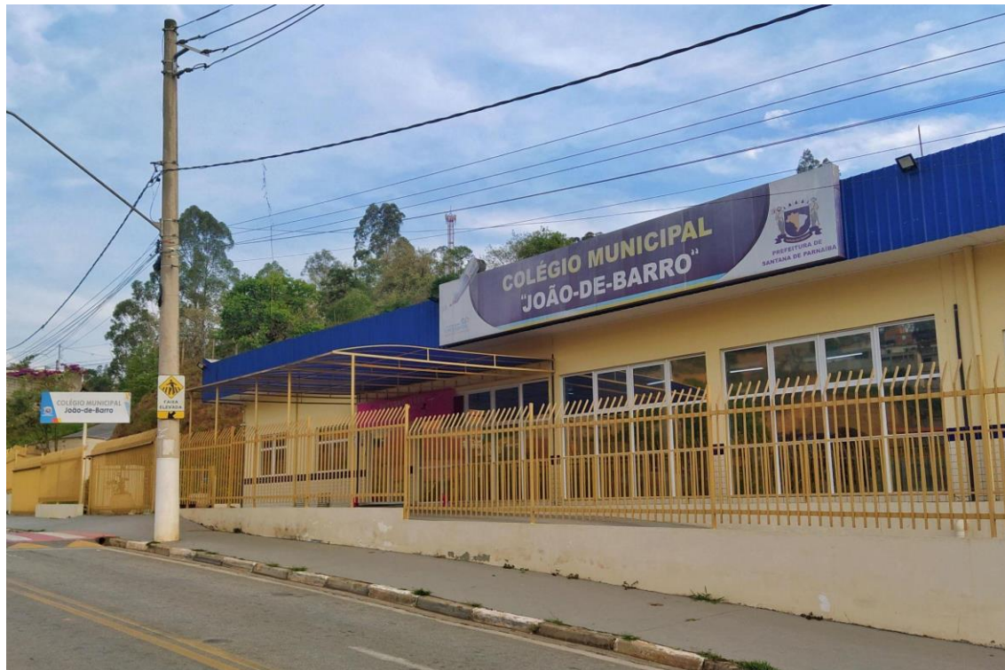
Figura 24: Colégio Municipal João de Barro construído pela "RZK Empreendimentos".
