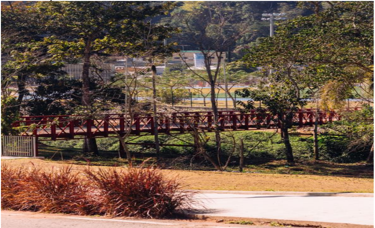
Figura 33– Passarela de acesso entre o Museu de Artes Osório Cesar e o Parque Municipal Benedito Bueno de Moraes.
