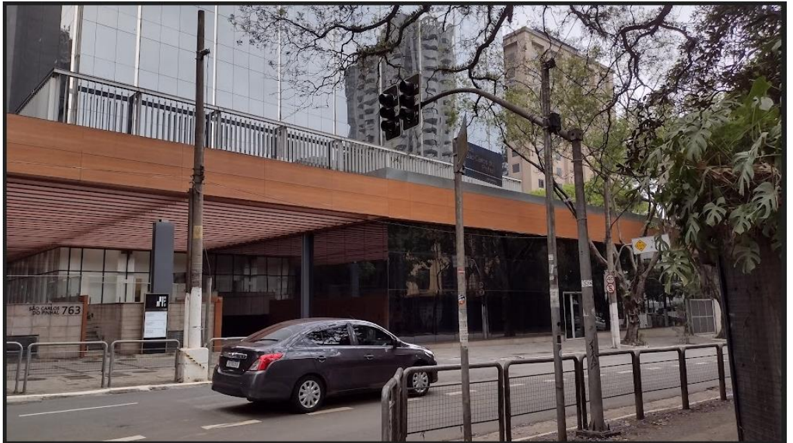
Figura 17. Rua São Carlos do Pinhal - Prédio Brazilian Financial Center (BFC).
