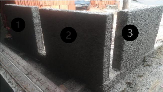
Figura 20. Painéis chapiscados com pó de brita.
