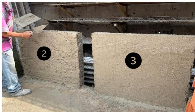
Figura 21. Realização do emboço nos painéis 2 e 3.
