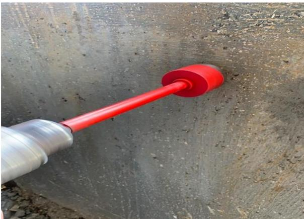
Figura 24. Perfuração do substrato com serra copo com diâmetro de 50mm.
