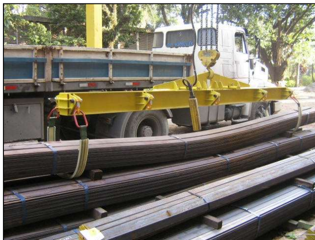
Figura 24- Abastecimento de barras chatas
