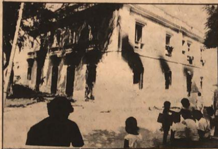
Os sinais da destruição no prédio da Prefeitura
