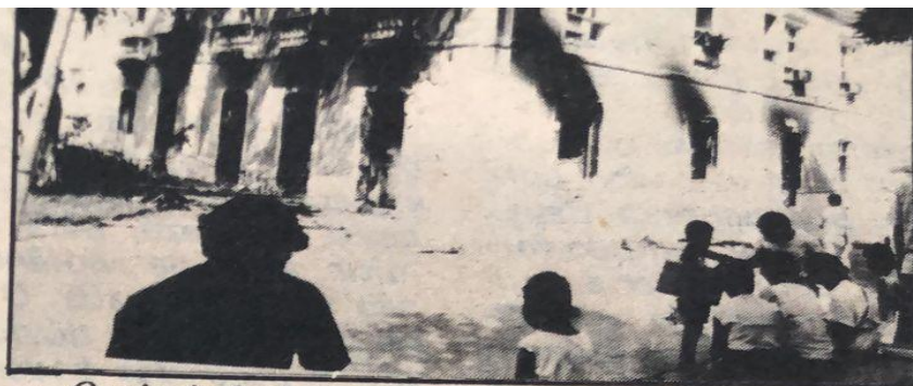
Os sinais da destruição no prédio da Prefeitura
