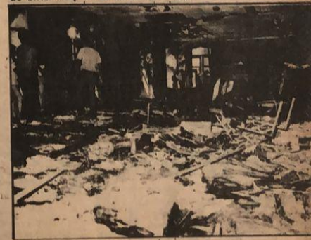
Tudo destruído pelo incêndio da terça-feira
