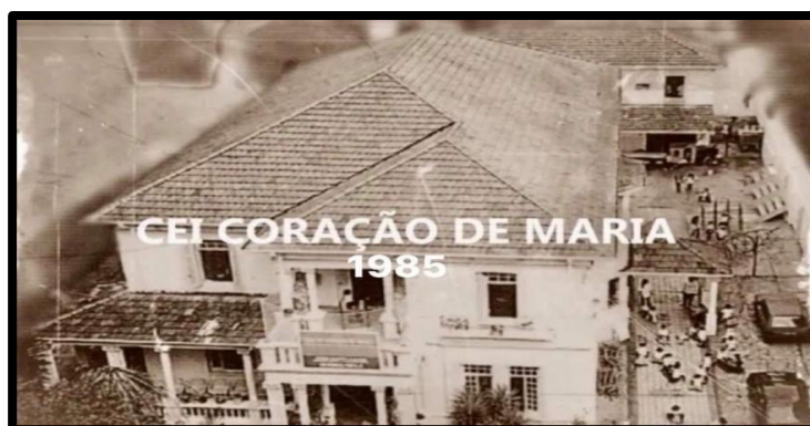
Figura 4 - Fachada antiga do Centro de Educação Infantil
