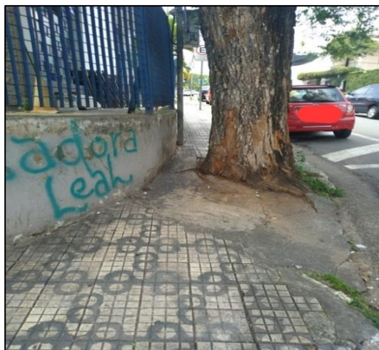
Figura 9: Espécie arbórea inadequada para plantio em via pública. Localizada na Av. Índico com Rua Banda, Jardim do Mar, SBC.
