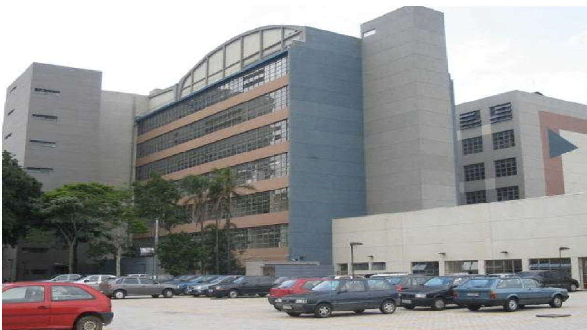
FIGURA 2 - Escola Têxtil Central do Brás
