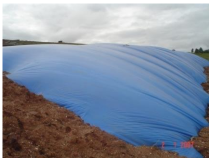
Figura 10: Lona instalada no talude.
