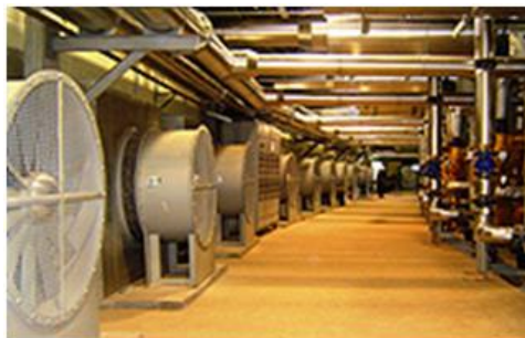
Figura 18: Motogeradores instalados na UTE – São João
