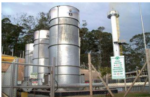
Figura 17: Flares instalados no Projeto São João
