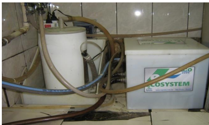
Figura 7: Estação de Tratamento dos resíduos das processadoras de filmes radiológicos Fonte: Hospital Público (2010)
