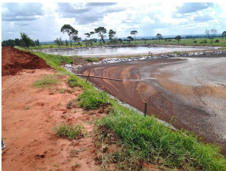
Figura 13: Lagoas para efluente tratado pelo biodigestor. Fonte: Arquivo pessoal do autor.
