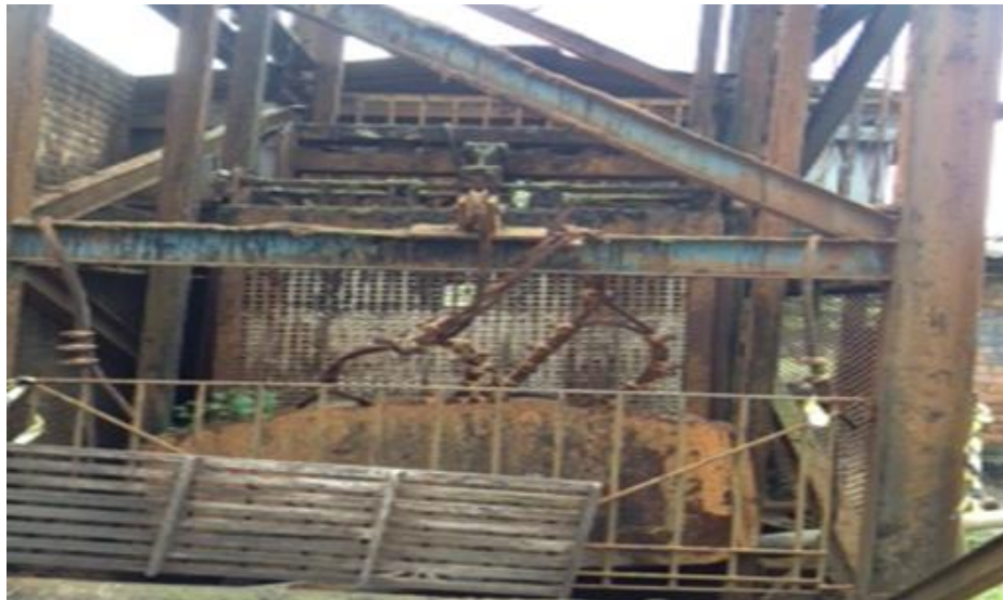
FOTOGRAFIA 1 - Estrutura de elevador de mina antiga
