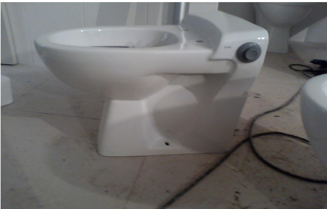
Figura 9 - Acionador instalado nos vasos sanitários
