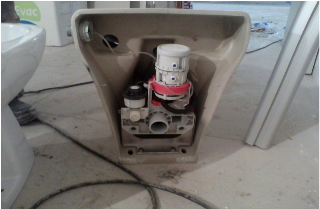
Figura 10 - Sistema de acionamento dos vasos sanitários
