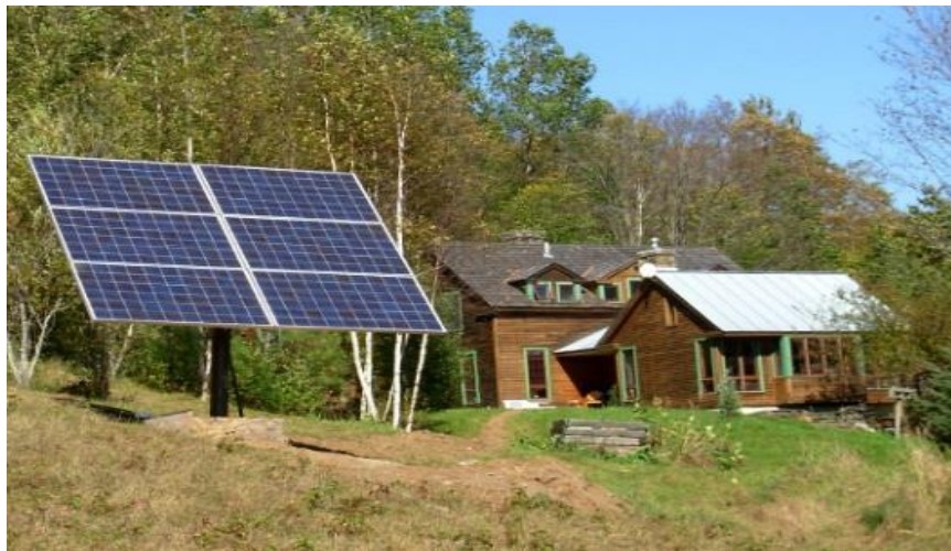
Figura 9 - Sistema fotovoltaico de geração isolada
