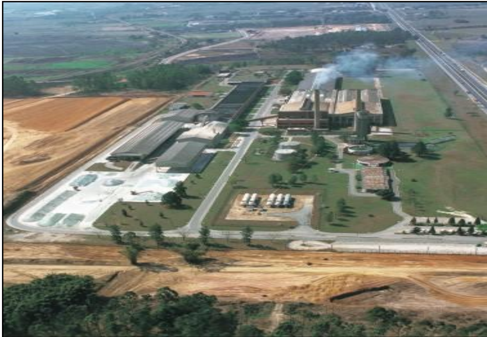
Figura 1 – Vista panorâmica da Providro e da terraplenagem para a construção da Cebrace II, que seria inaugurada em 1989.
