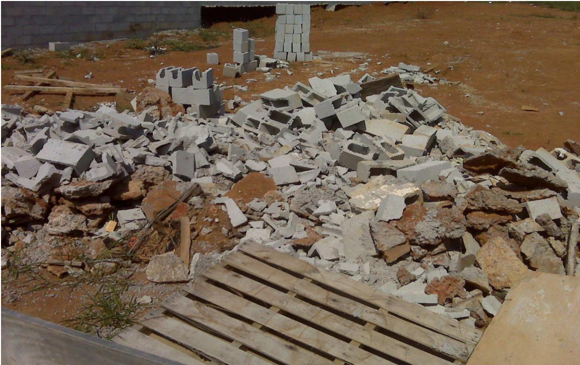
Figura 59. Imagem dos RCC a serem utilizados na melhoria das vias internas da obra. Fonte: PGRCC – Obra 3 – Suzano.
