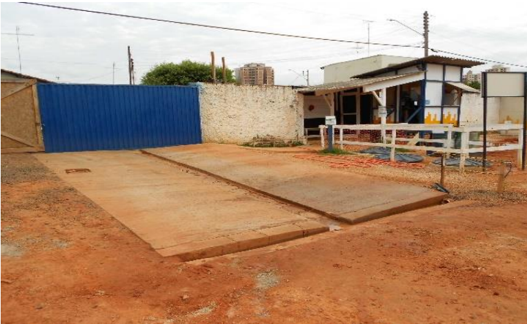
Figura 55. Imagem do Lava Rodas com reservatório e caixas para decantação. Fonte: PGRCC – Obra 3 – Suzano.
