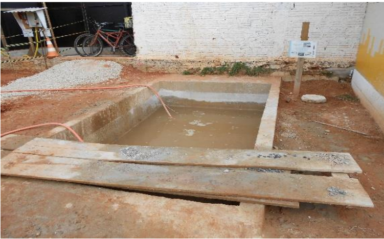
Figura 56. Imagem do Lava Bica para betoneiras móveis (caminhões) e manuais. Fonte: PGRCC – Obra 3 – Suzano.
