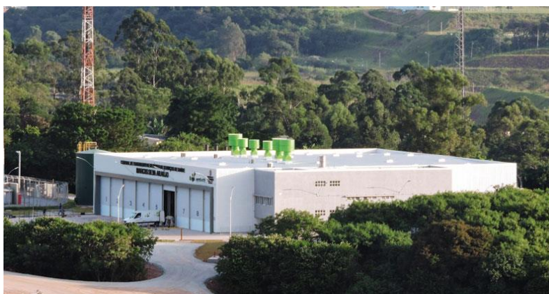
Figura 26. Central de Tratamento de RSS (grupo A e E). Fonte: Logística Ambiental de São Paulo S.A.
