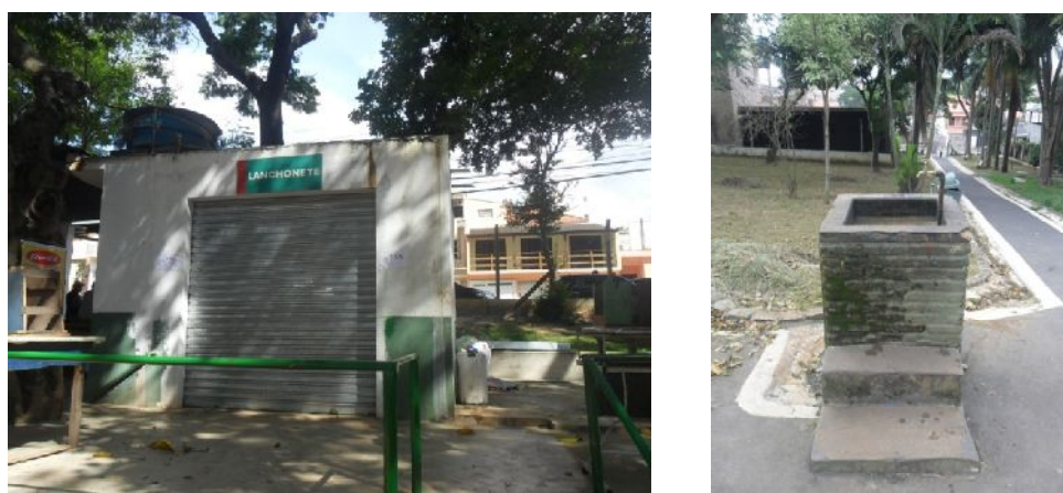
Figuras 17 e 18. Lanchonete e bebedouro, ambos localizados no parque de Lazer Antônio Temporim, Vila Jaguaribe, Osasco, SP.
