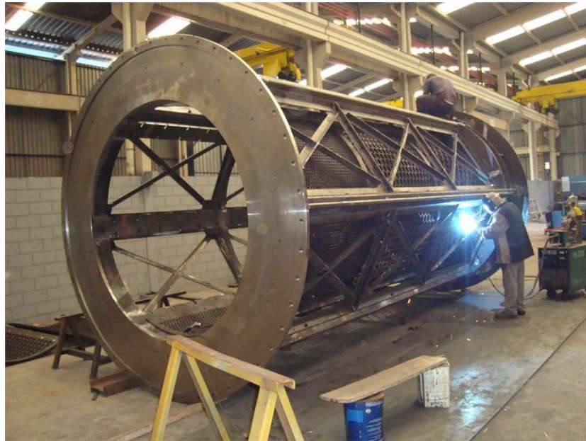
Figura 11 - Soldagem em peça de Caldeiraria
