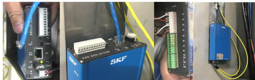
Figura 29 - IMx-8 no painel da máquina
