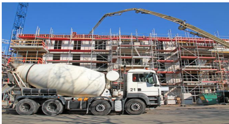
Figura 9: Caminhão Betoneira Conectado.
