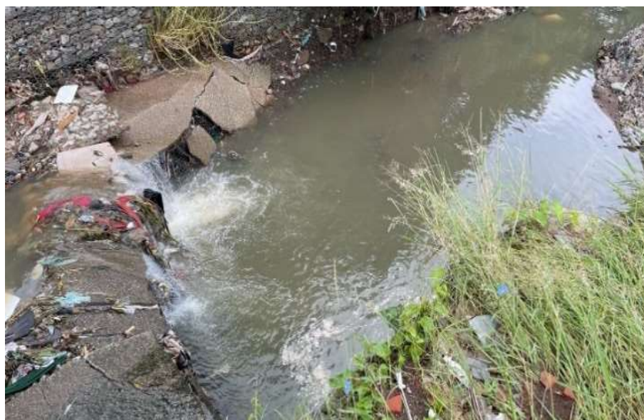
Figura 47. Detalhe do degrau hidráulico em frente ao local rompido Fonte: Dados da pesquisa
