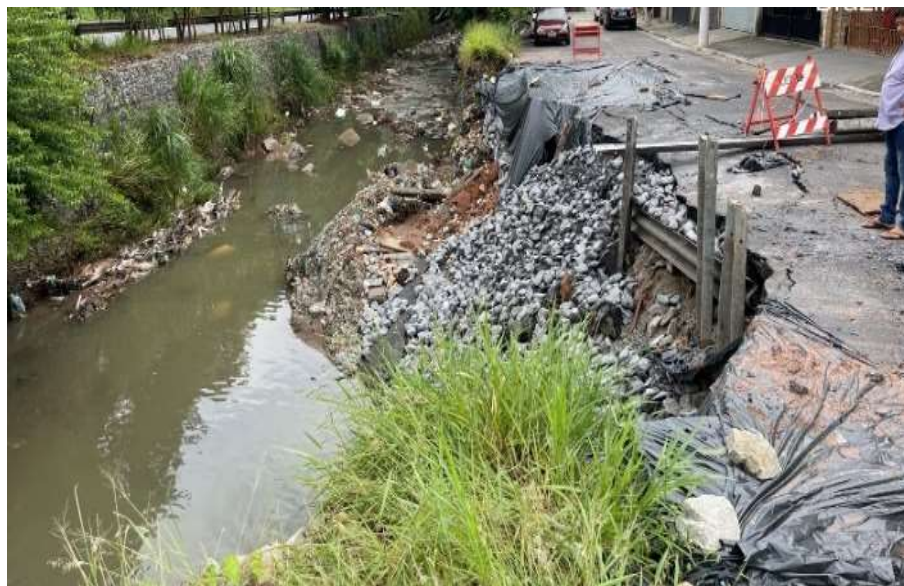
Figura 46. Vista geral do local e contenção provisória Fonte: Dados da pesquisa
