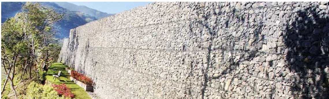
Figura 3. Estrutura de contenção feita com gabião Fonte: Maccaferri (2021)
