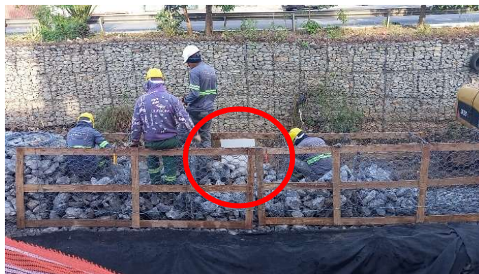
Figura 53. Posicionamento da placa de MDF entre a malha e as pedras Fonte: Autoria própria
