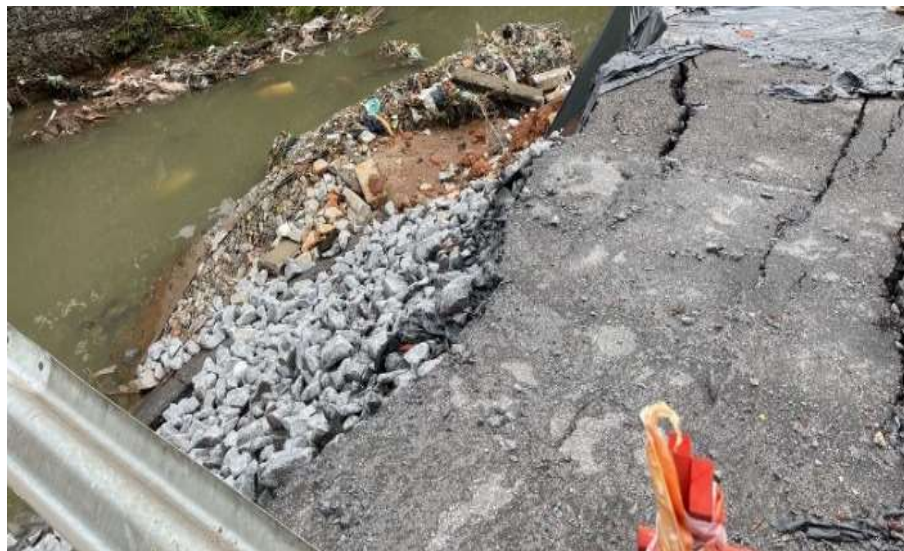
Figura 45. Local de colapso e rachaduras no pavimento devido a movimentação do solo Fonte: Dados da pesquisa
