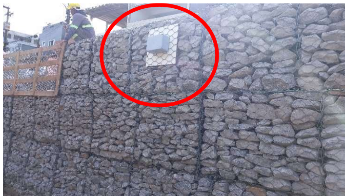
Figura 54. Dispositivo IoT instalado na contenção Fonte: Autoria própria
