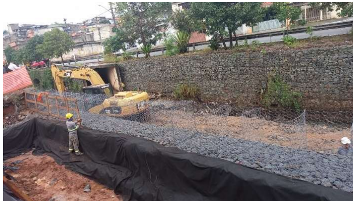
Figura 52. Execução da amarração das gaiolas Fonte: Autoria própria
