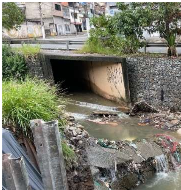
Figura 48. Galeria de águas pluviais situada em frente ao local rompido Fonte: Dados da pesquisa
