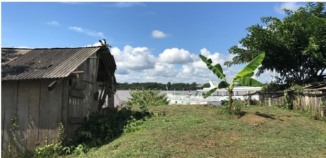
Imagem 12: instalações da “sociedade da farinha” praticamente soterradas pela inundação – 19/05/2019
