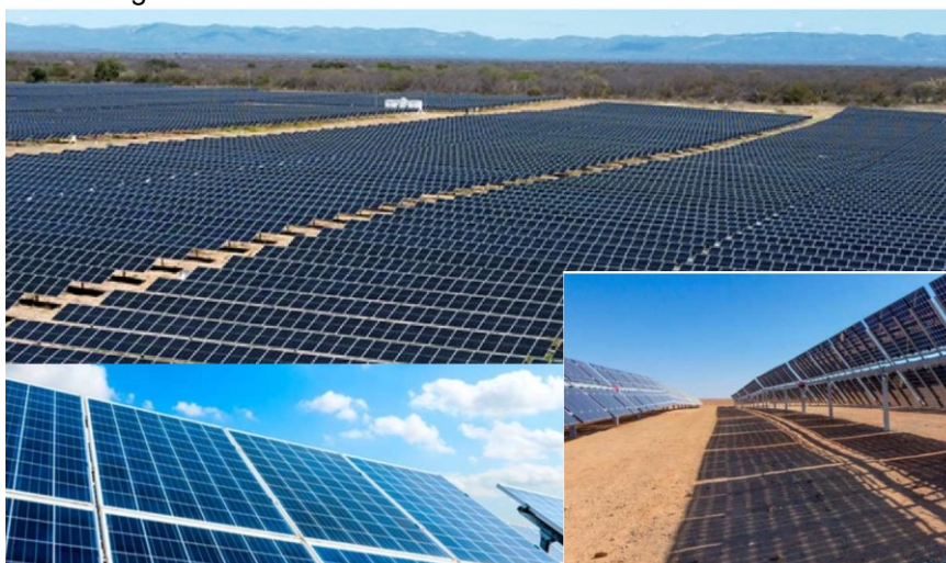
Figura 1: Detalhes de usina fotovoltaica em Minas Gerais.
