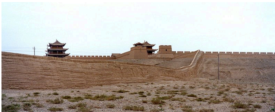
Figura 1. Seção da Muralha da China construída em taipa, China, século II a.C.
