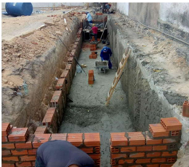
Figura 20. Execução da Bacia de Evapotranspiração.
