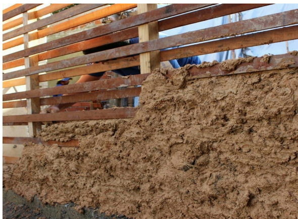
Figura 8. Barreamento do pau-a-pique
