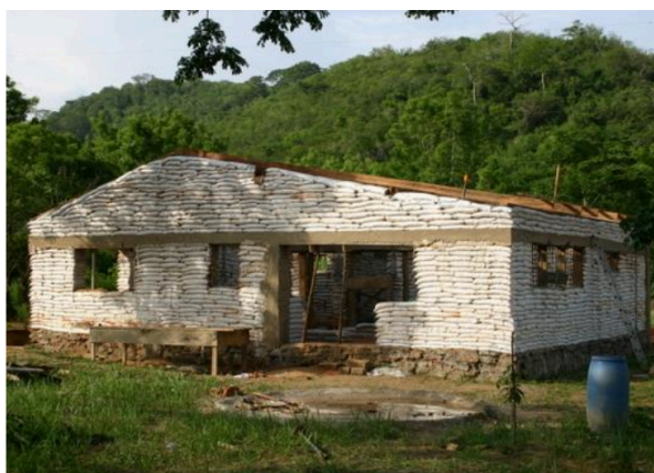
Figura 10. Técnica da terra ensacada
