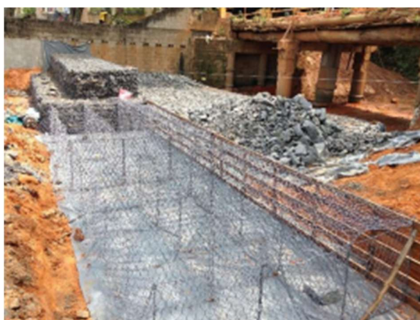
Figura 31. Locação e preenchimento dos gabiões caixa. Fonte: Paschoalin Filho et al., 2020.
