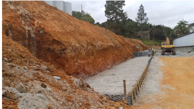
Figura 58. Etapa inicial da construção do muro com a primeira camada em gabião Fonte: De autoria própria
