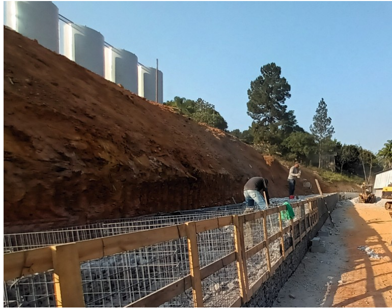
Figura 60. Uso dos gabaritos na face dos gabiões Fonte: De autoria própria
