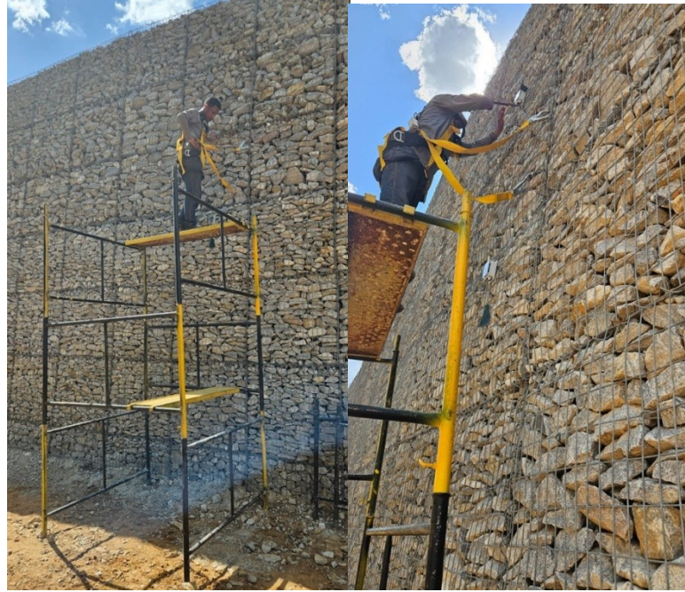
Figura 63. Estrutura de andaime para colocação e retirada dos sensores Fonte: De autoria própria
