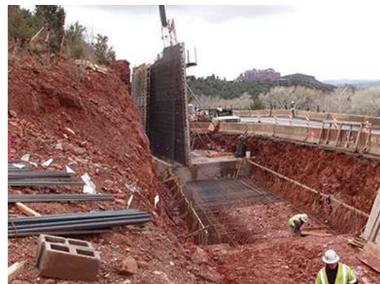
Figura 4. Muro de flexão em construção Fonte: Gerscovich et al. (2016)
