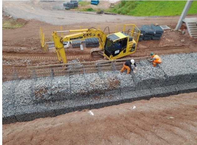
Figura 26. Enchimento das caixas de gabião eletrosoldado Fonte: De autoria própria
