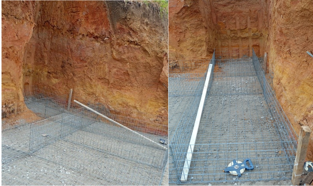
Figura 57. Demarcação do terreno e início da montagem dos painéis dos gabiões
