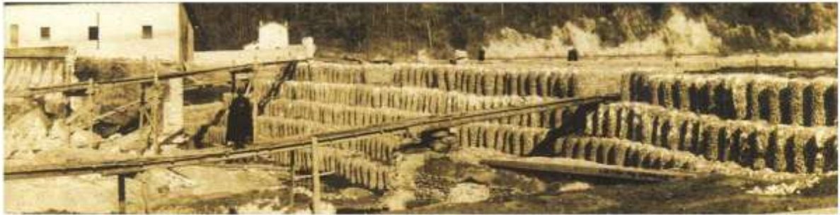
Figura 12. Contenção das margens do Rio Reno no norte da Itália Fonte: Agostini et al. (1981)
