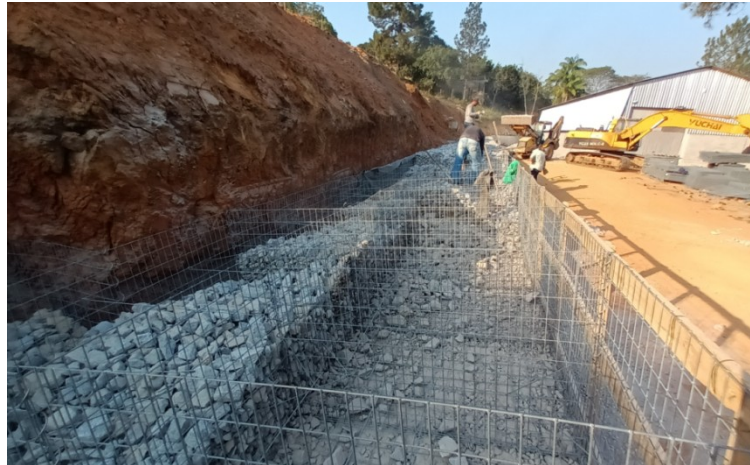
Figura 59. Preenchimento das caixas e posicionamento dos tirantes Fonte: De autoria própria
