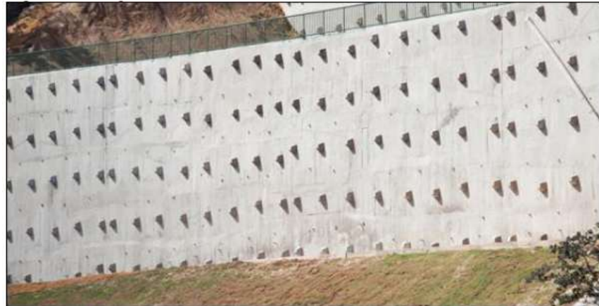
Figura 5. Muro de cortina atirantada Fonte: Porto (2017)
