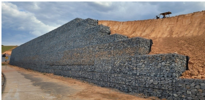
Figura 8. Muro de solo reforçado com face em gabião eletrosoldado
