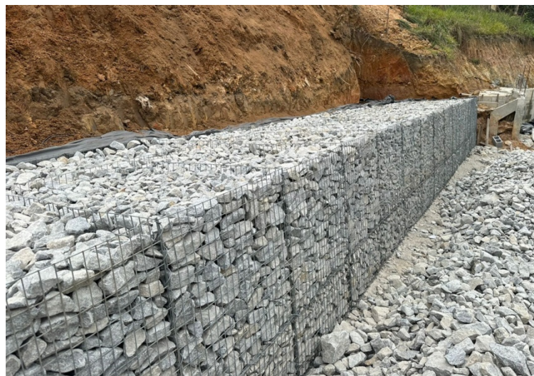
Figura 61. Face alinhada dos gabiões e com preenchimento correto Fonte: De autoria própria
