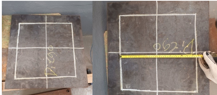
Figura 73. Chapas de aço com gabarito para apoio dos gabiões Fonte: De autoria própria
