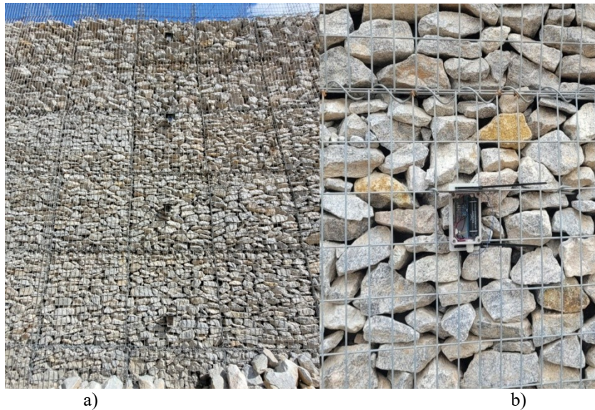
Figura 64. Sensores instalados no muro: a) Alinhamento dos 4 sensores; b) Detalhe do sensor instalado Fonte: De autoria própria
