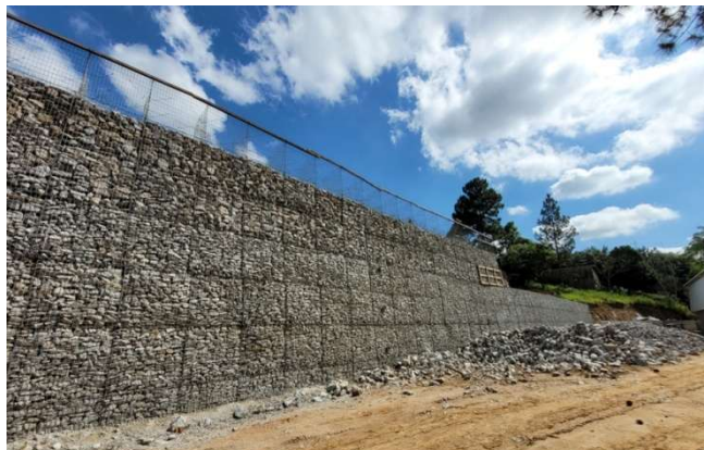
Figura 54. Muro de contenção com gabião eletrosoldado Fonte: De autoria própria
