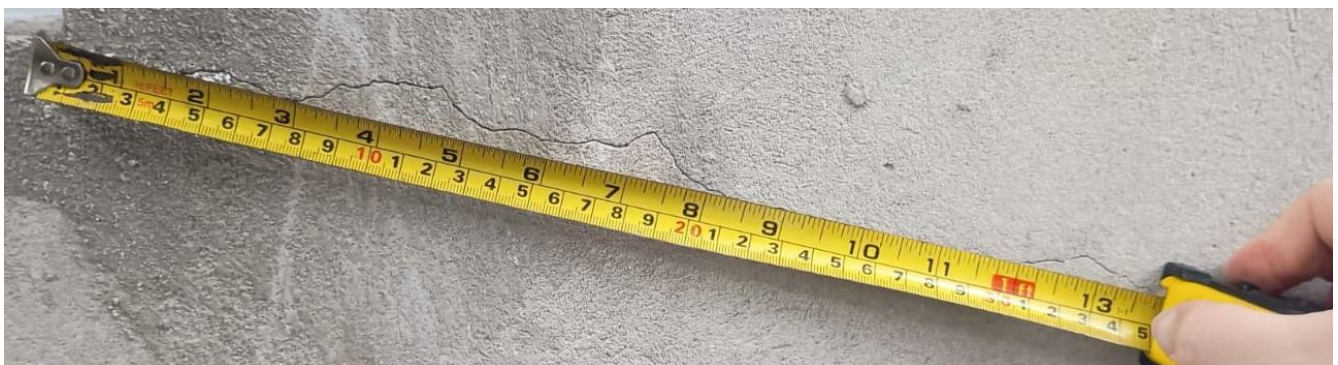
Figura 4: Mensuração de extensão de uma fissura
